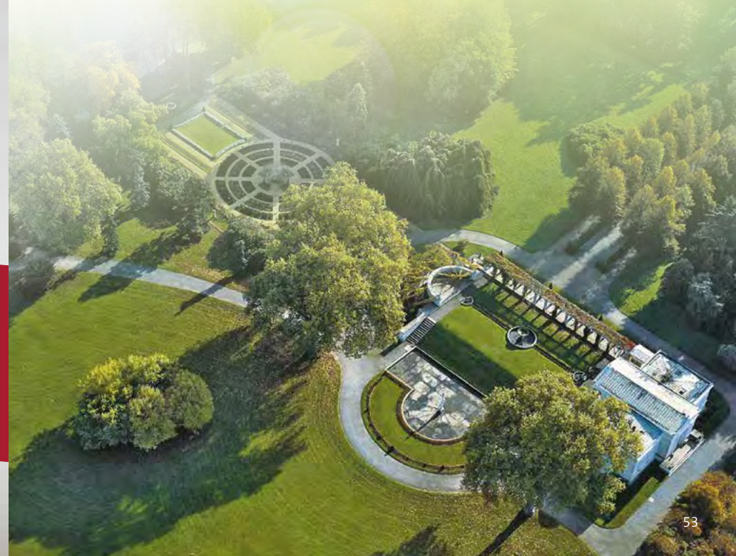
Luftaufnahme von Schloss Charlottenhof
